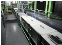
地下ピットスペース利用
